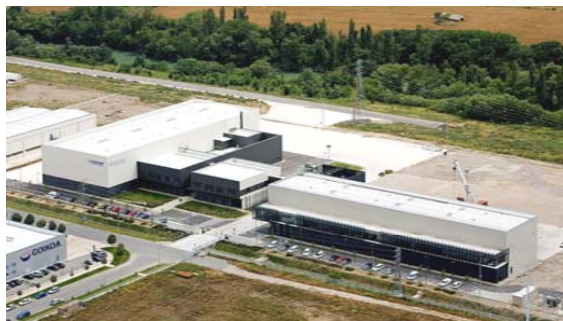
Laboratorio de Ensayo de Aerogeneradores Sangüesa
